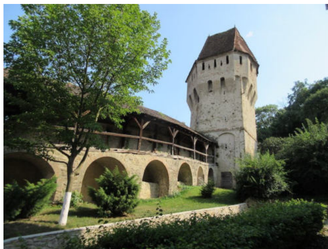
Wehrgang mit Zinngieberturm im ev. Pfarrhof
